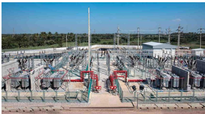
ภาพที่ 2.43 งานก่อสร้างประเภท : สาธารณูปโภคอื่นๆ
